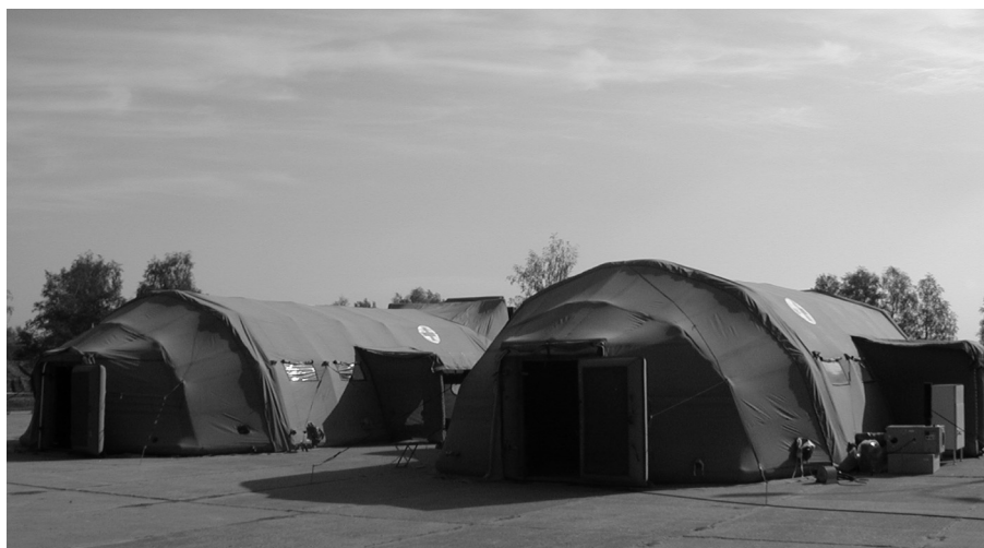
Рис. 2. Пневмокаркасные сооружения медицинские типа ПСМ-6
