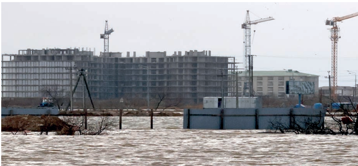
Подтопление территории в г. Евпатории, 27.11.2023 г. [фото С. Мальгавко, https://rg.ru/ ].
